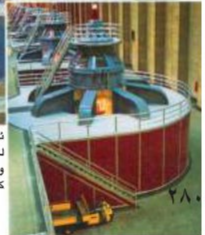
ناوى كۆكراووى بەنداو كە لە چەند كۆنىكە بان لە چەند دەركاىەكەو دەرتنە سەر پەروانەكان و دەیانخولىتتەو و پەروانەكانىش دىنەمۆى كارەباىيەكان دەخولىتتەو.
